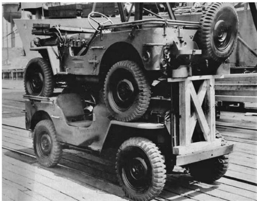
Aanzicht van twee gestapelde jeeps op Pier 2, Hampton Roads Port of Embarkation, voordat ze op het dek van een Liberty schip werden geplaatst.
